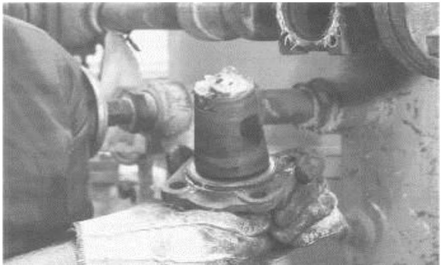
Вентили, защищенные устойчивой к химикатам смазкой для вентиляей **MOLYKOTE 3452**, не проявляют признаков коррозии или распада смазки.
